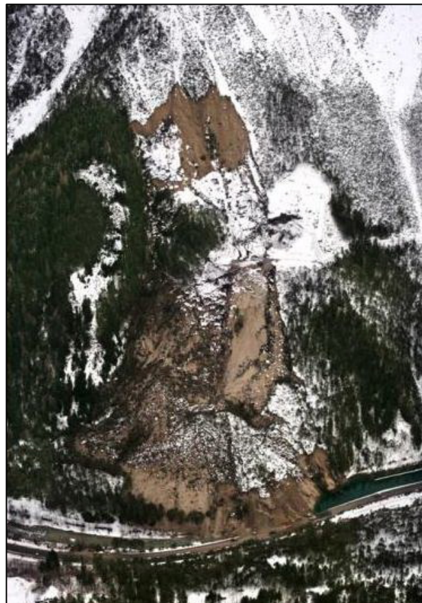
Abb.1.: Gesamtansicht der Rutschmasse (Foto Baubezirksamt Lienz)
